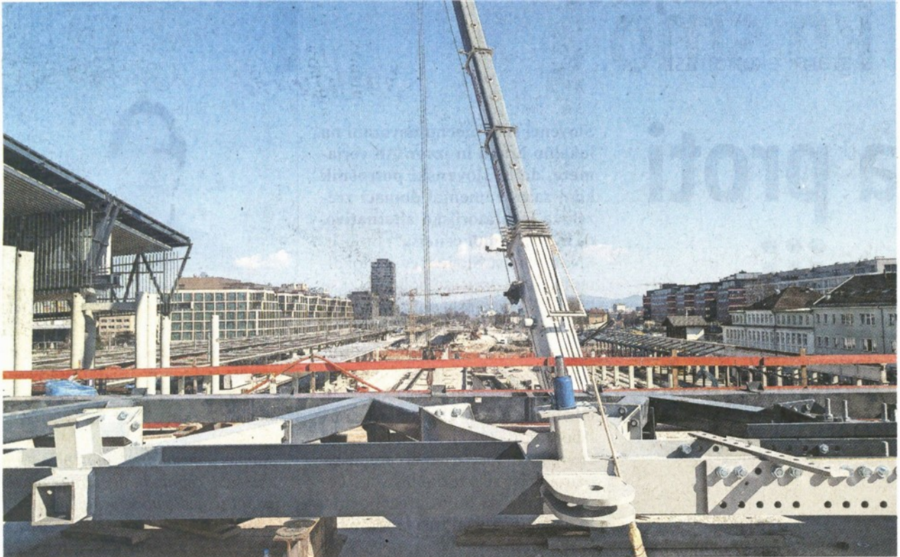
Glavna železniška postaja v Ljubljani je eno največjih gradbišč v državi. / Foto: STA
